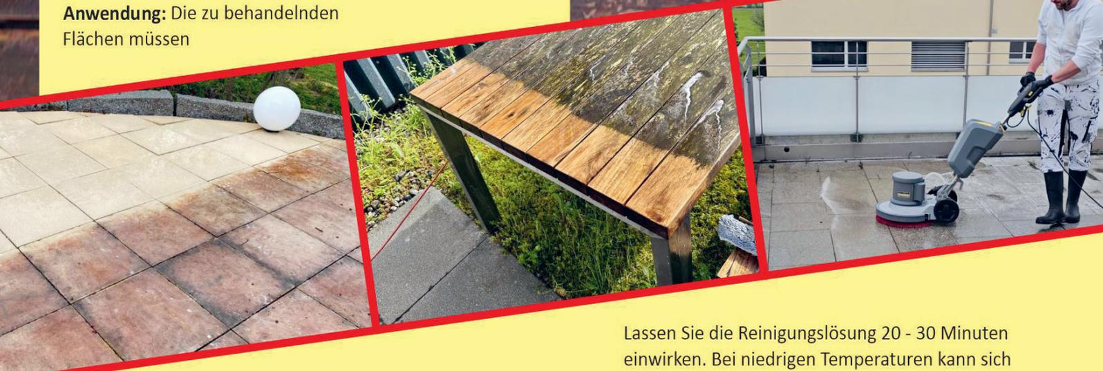
trocken und frei von Verschmutzungen wie Laub und Moos sein. Mit Sprühgerät in einem Abstand von ca. 20 - 30 cm mit HTC 2K A einen dünnen, jedoch sättigenden Film auftragen. Die besprühten Flächen umgehend mit einem sättigenden Sprühfilm mit HTC 2K B überdecken. Sobald die beiden Komponenten A & B aufeinander treffen tritt sofort die Reinigungswirkung ein. Es bildet sich ein Schaumteppich mit Blasen.
